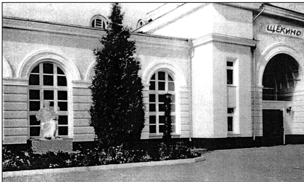
Станция Щекино. 2009 г.
