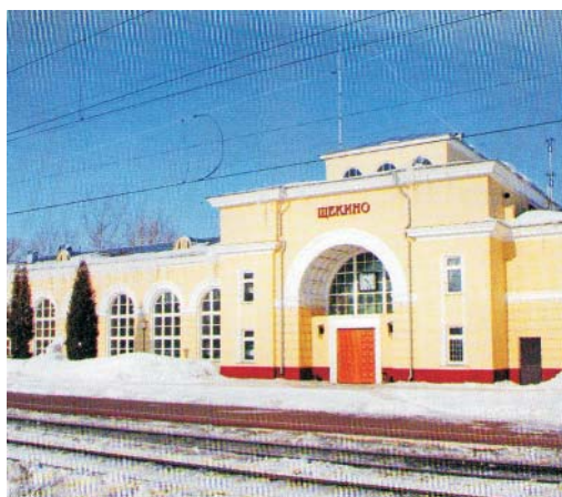
Станция Щекино. 2009 г.
